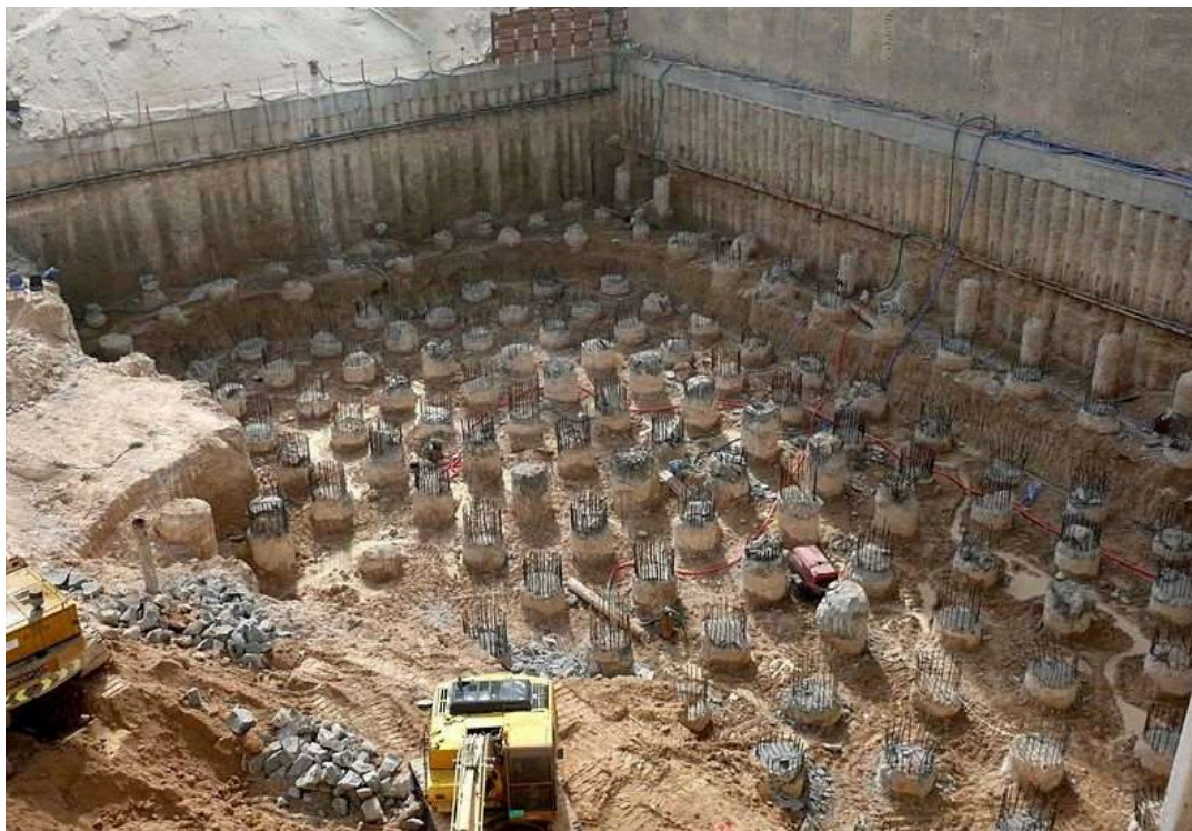
Fig.2 Fundația tip piloți, Marina 101 [5]
