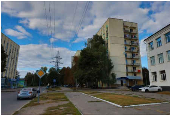
Рис. 1. Многоэтажный жилой дом, расположенный вблизи двухцепной ЛЭП. 1
