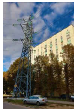
Рис.1. Жилой дом, расположенный вблизи двухцепной ЛЭП. 1
